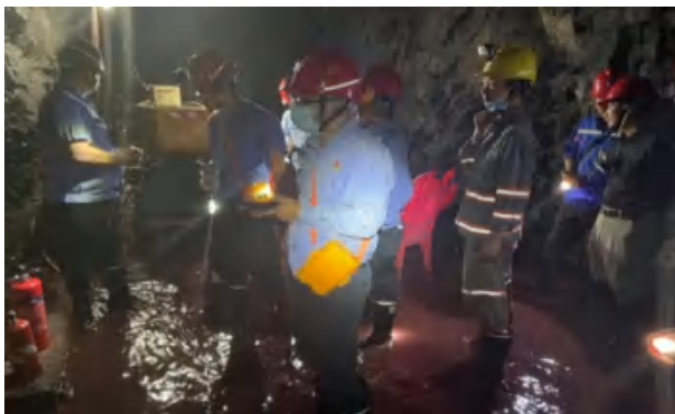
外委單位施工現場安全檢查
